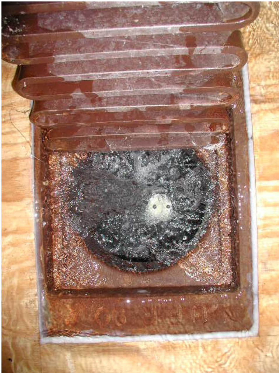
Placering af filter i nedløbsbrønd.
